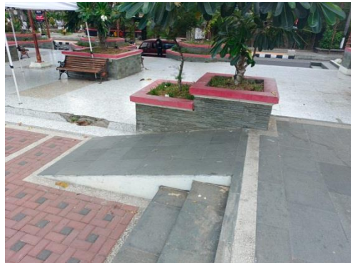
Gambar 2. Ramp yang terlalu curam, licin, dan tidak dilengkapi dengan handrailing
